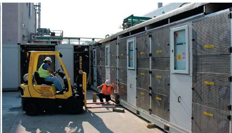
Рис. 2. Разгрузка и установка модулей DCoD (CommScore) предполагает использование автопогрузчика грузоподъемностью не менее 10 т
