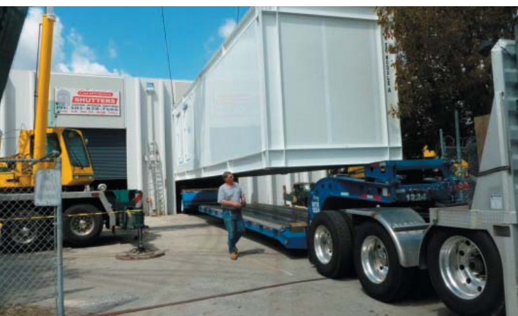
Рис. 1. Для разгрузки и установки модулей NON-ISO25 (МЦОД компании Schneider Electric) требуется кран грузоподъемностью не менее 25 т
